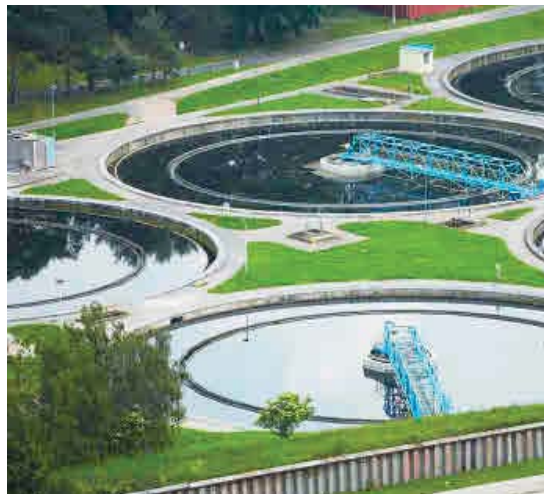
Vista general de depuradoras.
